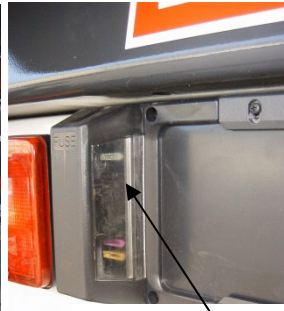
Alle Sicherungen sind im Verteilerkasten hinter den Kennzeichenleuchten angebracht.
